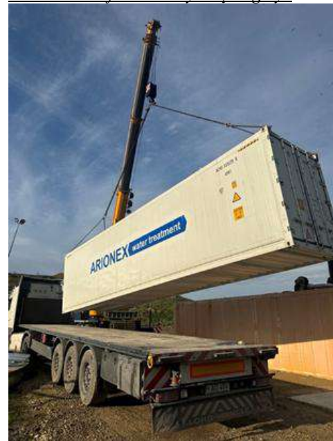
1 pav. Mobilus atvirkštinės osmozės membraninis filtrato valymo įrenginys
